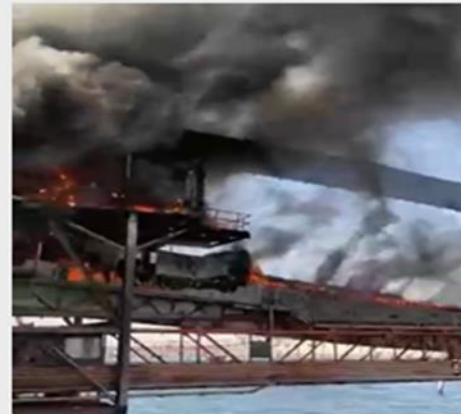
Incendio Puerto Mejillones
