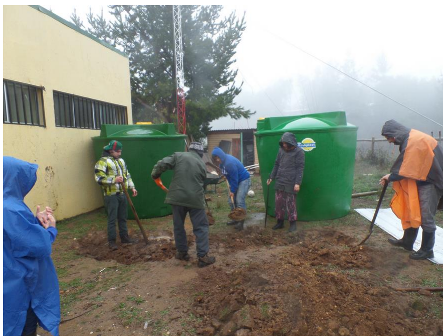
Figura 18: Instalación De Tanques Captadores de Aguas Lluvias, Comité de Aguas Salto de Agua.
